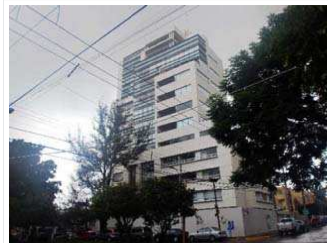
Torre Q Providencia. El TAE pidió demoler sus últimos cinco niveles. Foto: Marco A. Vargas
